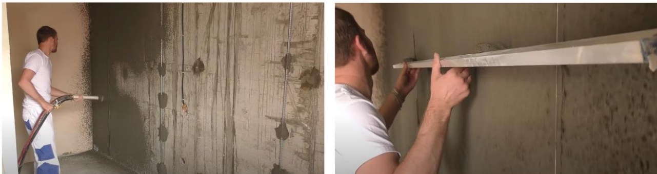
Рис. 26. Схема нанесения обрызга на поверхность и разравнивание правилами образовавшихся наплывов
